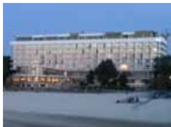
Sanatorium „BAŁTYK”, Kołobrzeg
